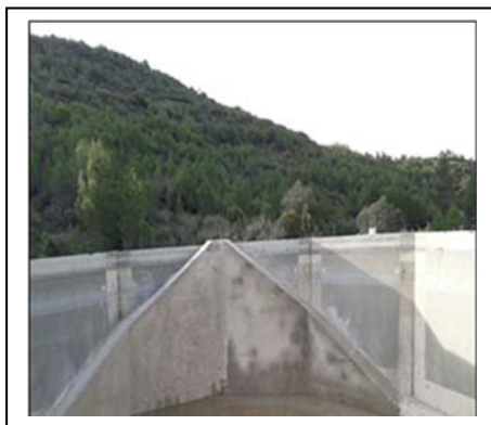
Imatge 20: Rampa de fauna d'obra per punt d'aigua.
