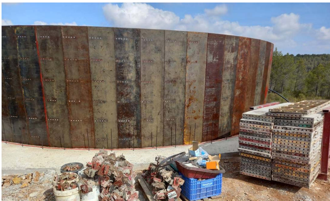
Imatge 16: Exemple d'encofrat en el punt d'aigua d'Avinyonet (PPP Garraf).
