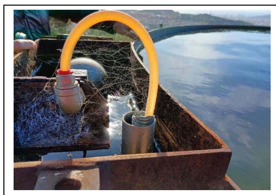
Imatge 17: Exemple del sistema d'abastiment automàtic amb boia de control
